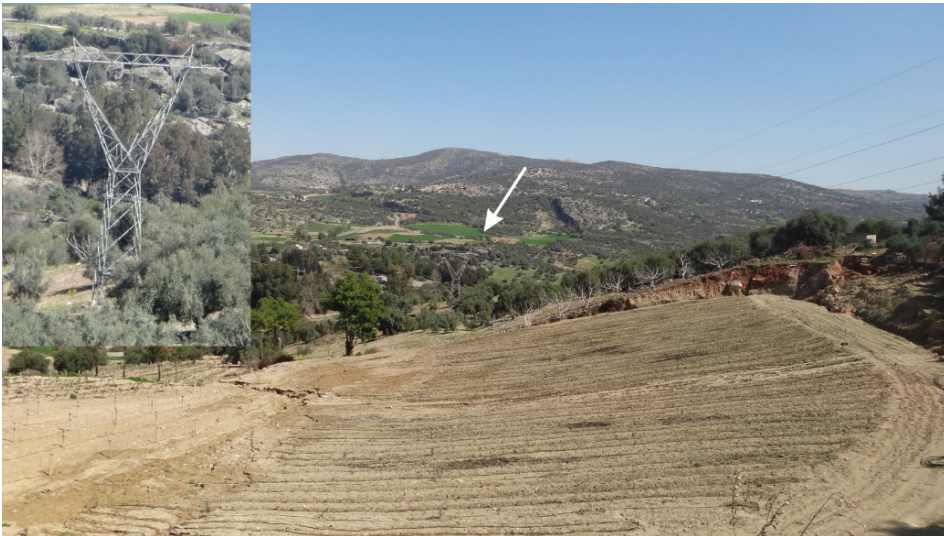
Şekil 2. Çalışma konusunu oluşturan elektrik direğinin genel görünümü.
