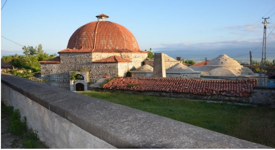
Foto. 1. Uluköy (Sonisa) Sinan Paşa Hamamı
