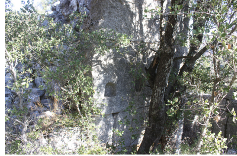
Fig. 10. D6 No'lu Konut İç Cepheden Polygonal Duvarlar ve Kata Ait Hatlı Yuvaları.
