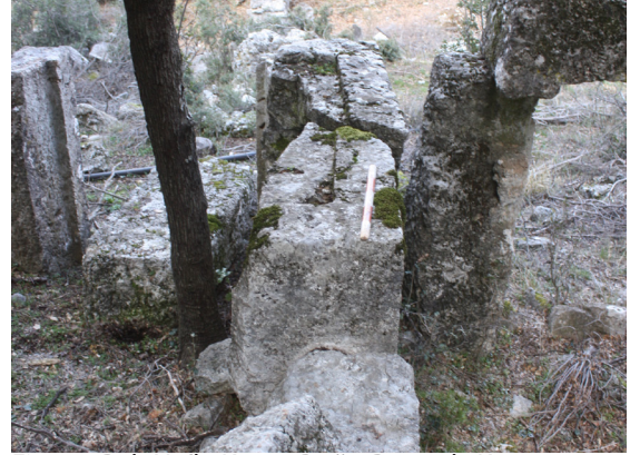
Fig. 23. D1b No'lu Konut Doğu Duvarda Korunmuş İkinci Kata Ait Kapı Eşiği
