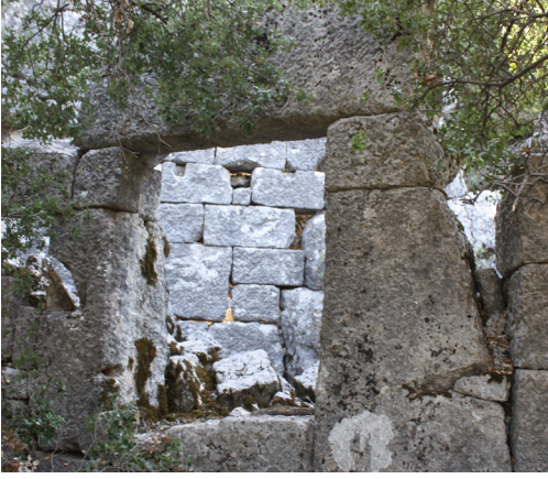
Fig. 51. B1 No'lu Konut Avlu Kapısı.
