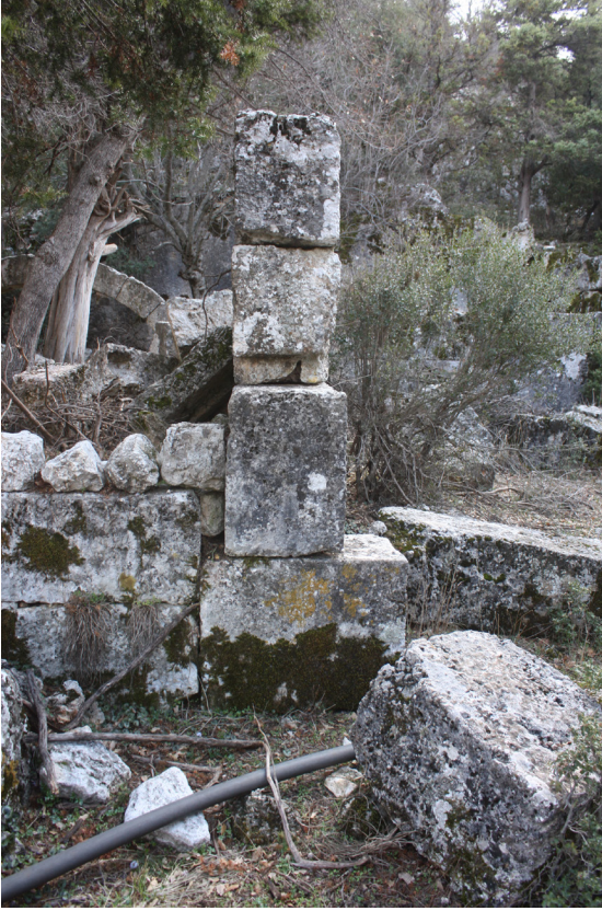
Fig. 21. D1a ve D1b'ye Ait Ortak Mekân Duvarı
