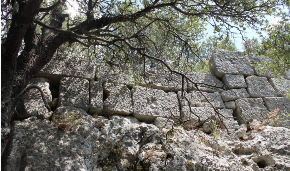
Fig. 86. D9 No'lu Konut Korunan Dış Cephe Duvarları
