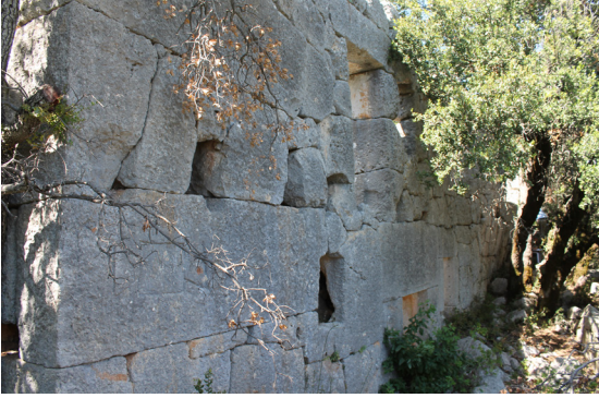
Fig. 3. D30 No'lu Konut Doğudan Görünüm.
