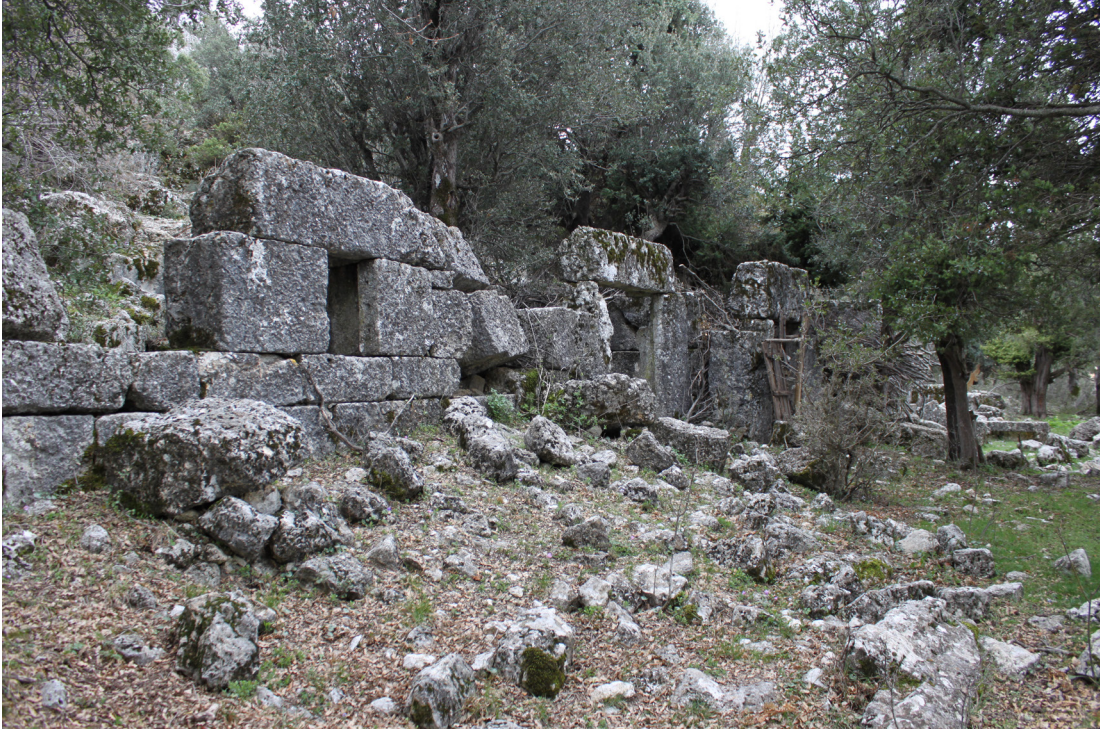
Fig. 14. D1 No'lu Konut Doğudan Görünüm.
