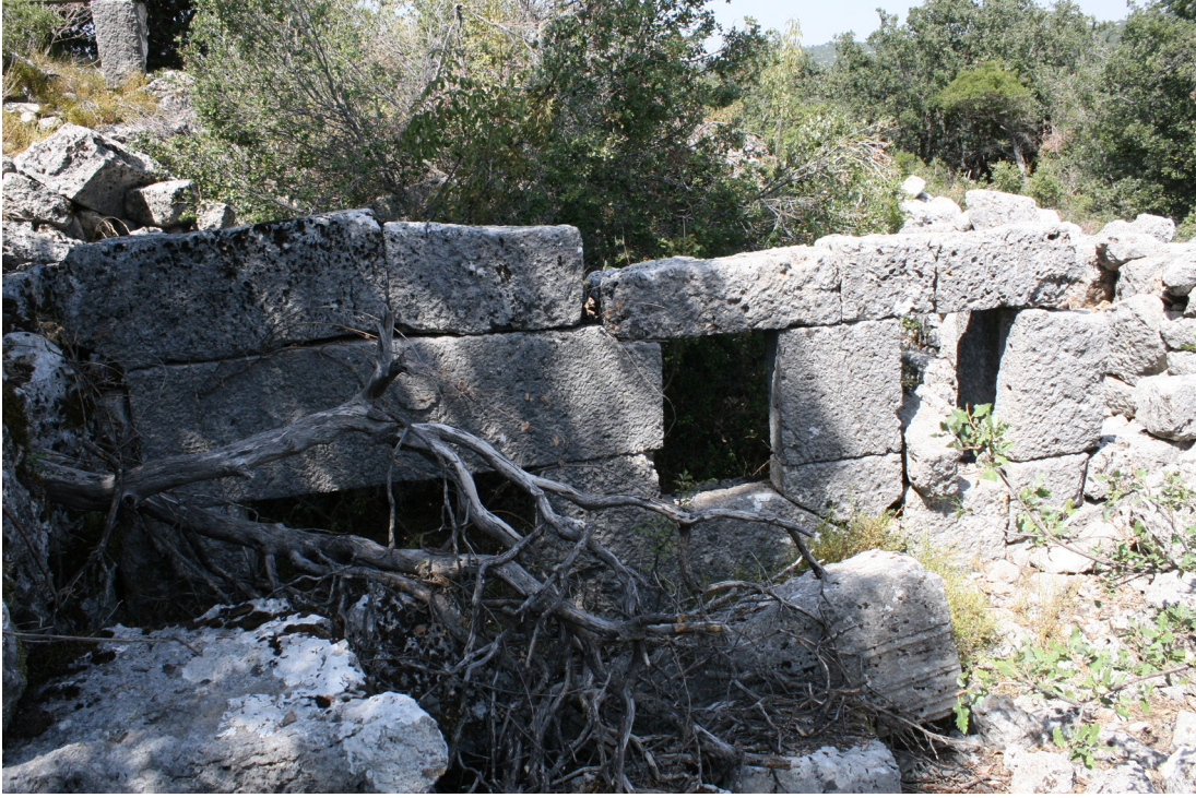
Fig. 74b. B18 No'lu Konut Mekâna Ait Kapı ve Pencereleler.
