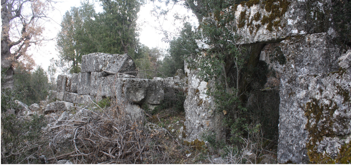
Fig. 27. D1c No'lu Konut Tonozlu Giriş.
