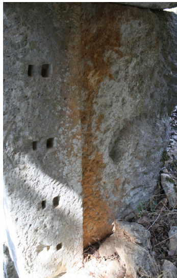
Fig. 8b. D30 No'lu Konut Ana Kapı Yanındaki Pencere Parmaklık Demir Yuvaları.
