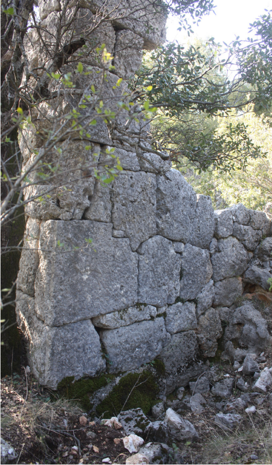
Fig. 11a. D6 No'lu Konut Doğu Köşe Polygonal Duvar Örgüsü.
