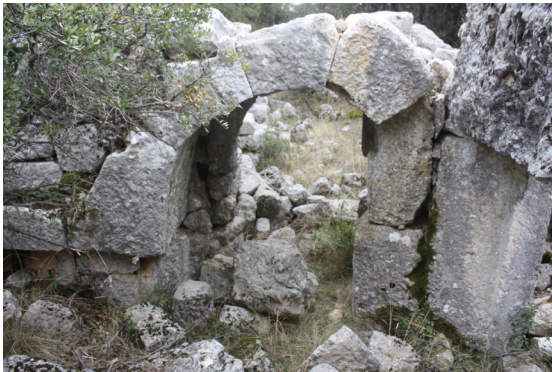
Fig. 63a. B8 No'lu Konut Mekânlar Arası Tonzlu Geçit Kuzeyden Görünüm.
