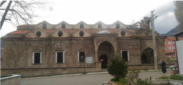
Şekil 8. Aya Yorgi Kilisesi kuzey cephesi [36]
