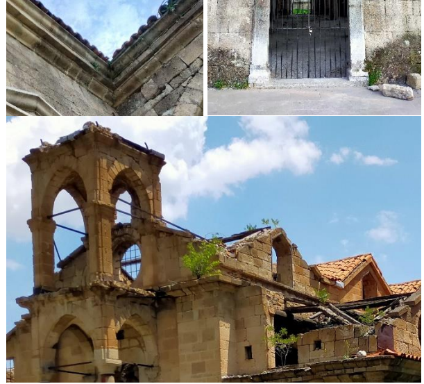
Şekil 22. Muhtelif cephelerdeki çiçeklenme, yosunlanma ve bitki oluşumları [36]
