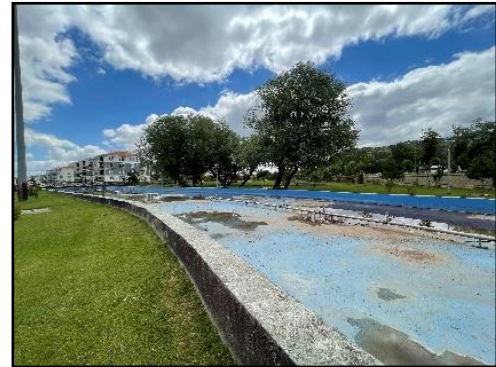
Şekil 15. Çalışma alanında bulunan süs havuzu
