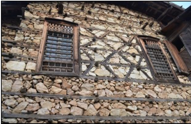
Foto. 1. Kuru Yığma Duvar Örneği (11.10.2015, Ormana Mahallesi).
