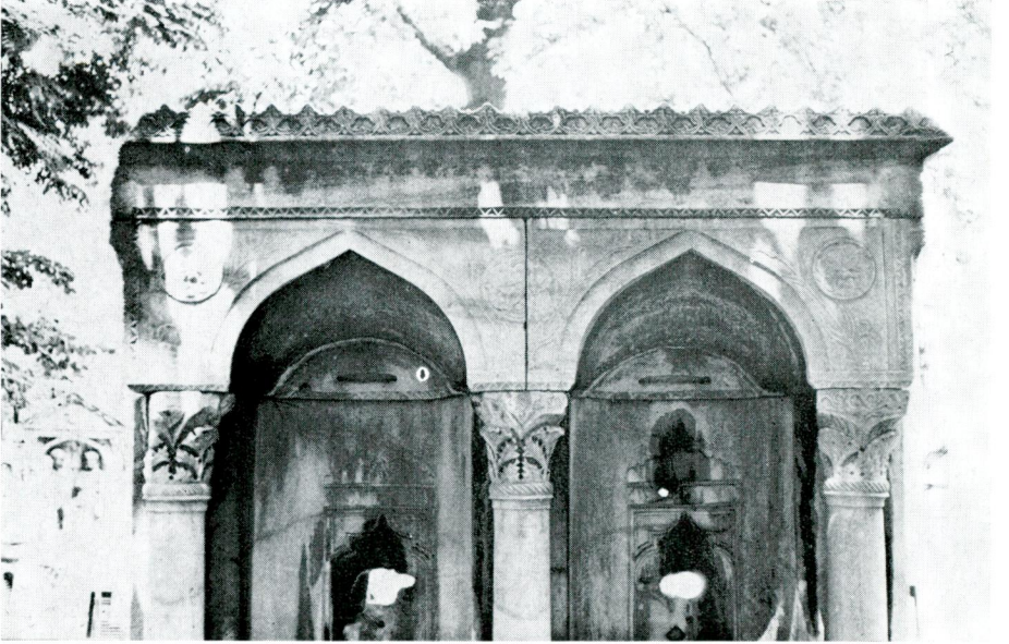
Res. 6 — Çeşmenin ön cephesi üst kısmı (Taç taşı düzeltildikten sonra)
