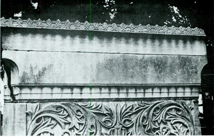
Res. 7 — Çeşmenin arka cephesi üst bölümü
