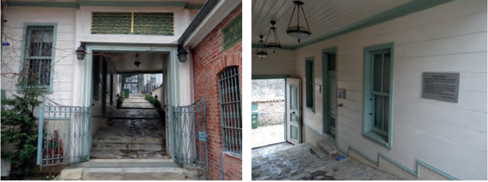
Şekil 8. Solda Yahya Efendi Külliyesi giriş taşılığı, sağda kapıcı başı odası görülmektedir (Hande Erdoğan,2016).
