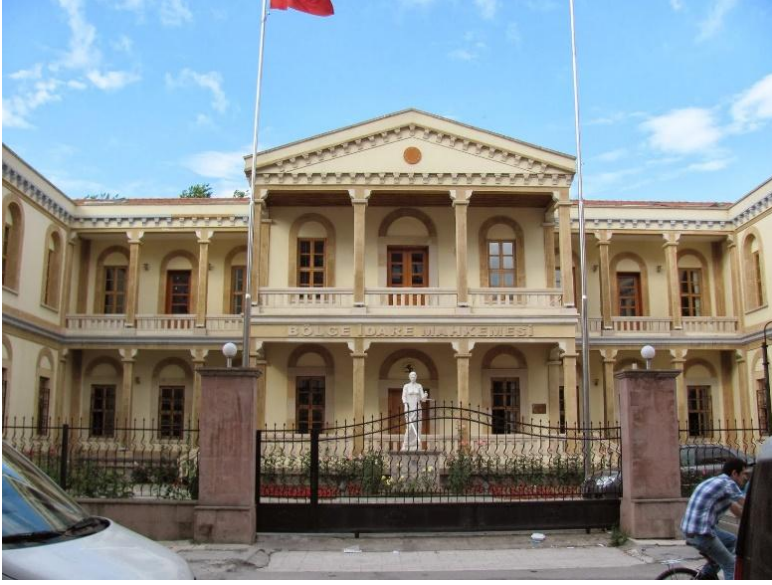
Foto.15: Samsun Hükümet Konağı giriş cephesi
