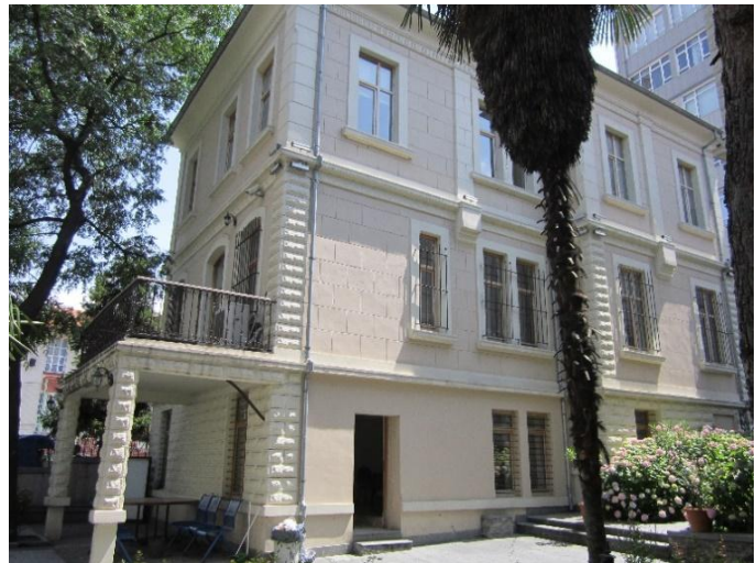
Foto.8: Şahinzade Remzi Bey Konağı kuzeybatı cephesi
