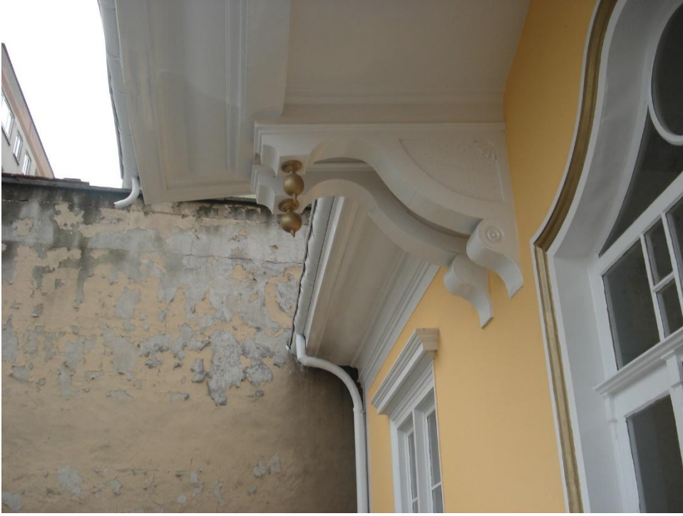
Foto.24: Eski TÖB-DER Binası/ Takas Odası konsollardan ayrıntı
