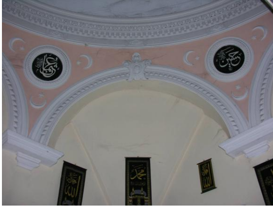
Fot.10-Emir Sultan Türbesi. Kubbeye geçiş bölgesi.
