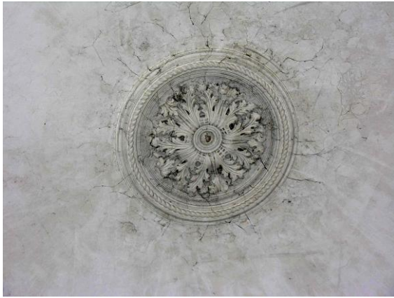
Fot.11. Emir Sultan Türbesi. Kubbe göbeği.
