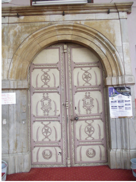
Fot. 16 - Ödemiş Ulu Cami, giriş açıklığını örten dökme demir kapı.
