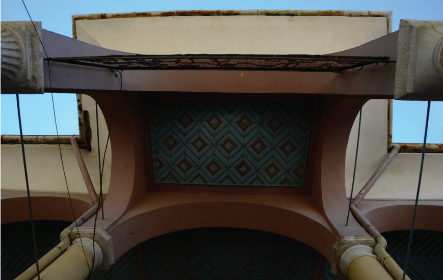
Fot. 13 - Ödemiş Ulu Cami, son cemaat yeri önünde dışa taşkın bölümün tavanı.
