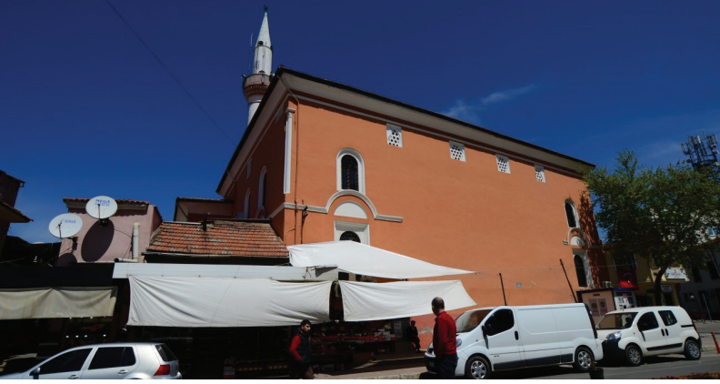
Fot. 8 - Ödemiş Ulu Cami, batı cephenin güney ucundaki dükkanlar.
