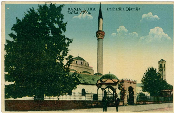
Ek 2: Ferhad Paşa Camii ve Saat Kulesi (Banaluka) 93
