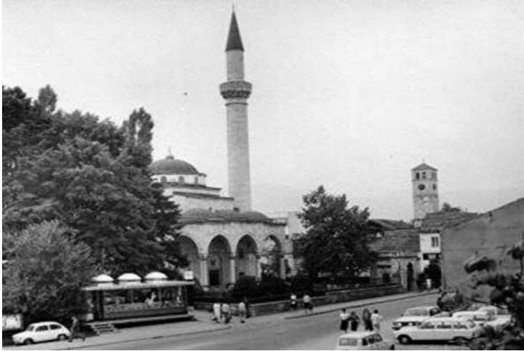
Ek 1: Ferhad Paşa Camii ve Saat Kulesi (Banaluka) 92
