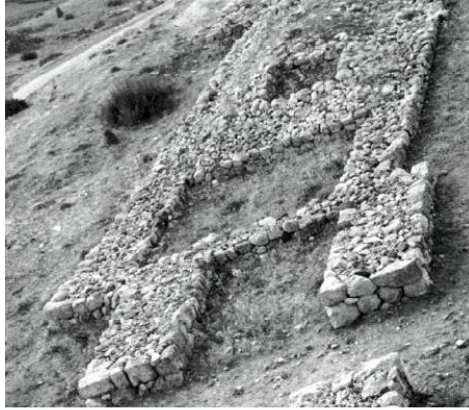
Resim-12 Bođazkő'den Sandık Duvar Yöntemi (Nossov, 2008)
