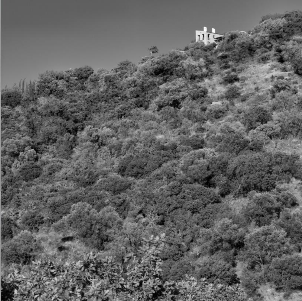
Şekil 4. Hasan Yörük Evi'nin tepe üzerindeki konumu, tek eğimli çatısı ( Epa Mimarlık, 2022 ) Figure 4. The location of Hasan Yörük House on the hill ( Epa Mimarlık, 2022 )
