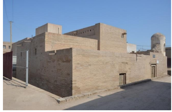
Foto-2. Mescit Güneydoğu Köşeden (E. POLAT, 2018)
