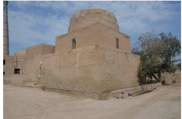
Foto-4. Mescit Batı Cephesi (E. POLAT, 2018)
