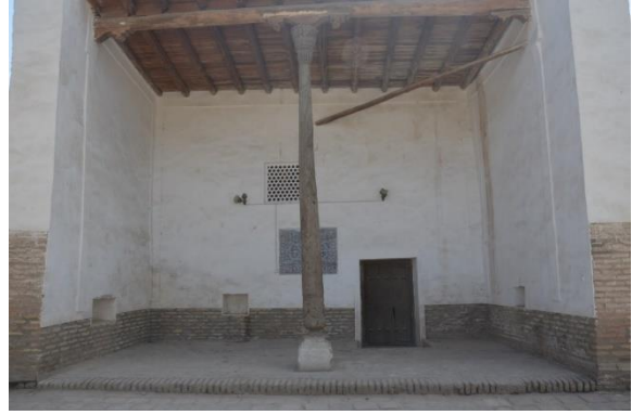
Foto-4. Mescit Kuzey Cephesi (E. POLAT, 2018)
