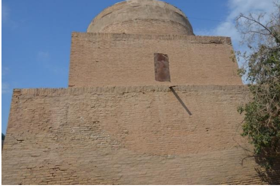
Foto-6. Mescit Kuzey Cephesi (E. POLAT, 2018)
