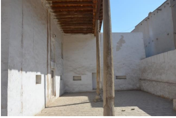
Foto-5. Mescit Batı Cephesi (E. POLAT, 2018)
