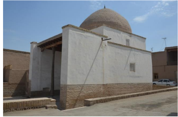
Foto-2. Mescit Batı Cephesi (E. POLAT, 2018)
