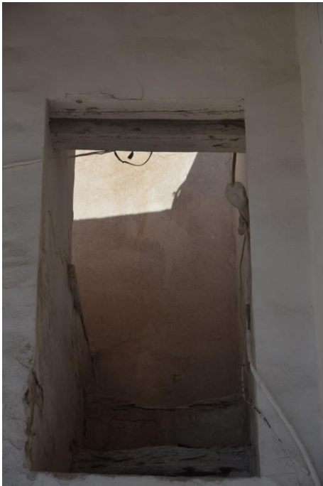
Foto-7. Batı Cephe Dama Çıkış Merdivenleri (E. POLAT, 2018)
