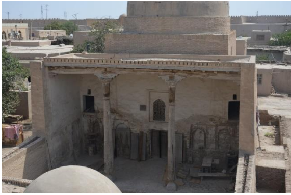
Foto-7. Mescit Kuzey Cephe (E. POLAT, 2018)
