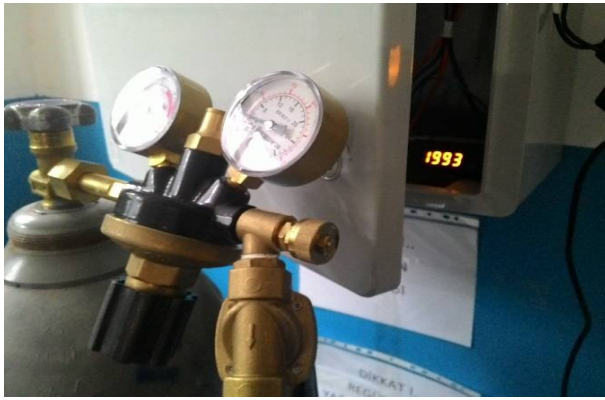
Şekil 1. Karbondioksit gübreleme ünitesi. Figure 1. Carbon dioxide dosing unit.
