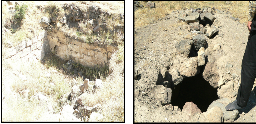
Fotoğraf 1. Kötükale tepe mevkiindeki tarihi sarnıçlar. Solda taşları için tahrip edilmiş bir sarnıç. Sağda ise bindirme tekniğinde kubbe ile örtülmüş bir başka sarnıç.
