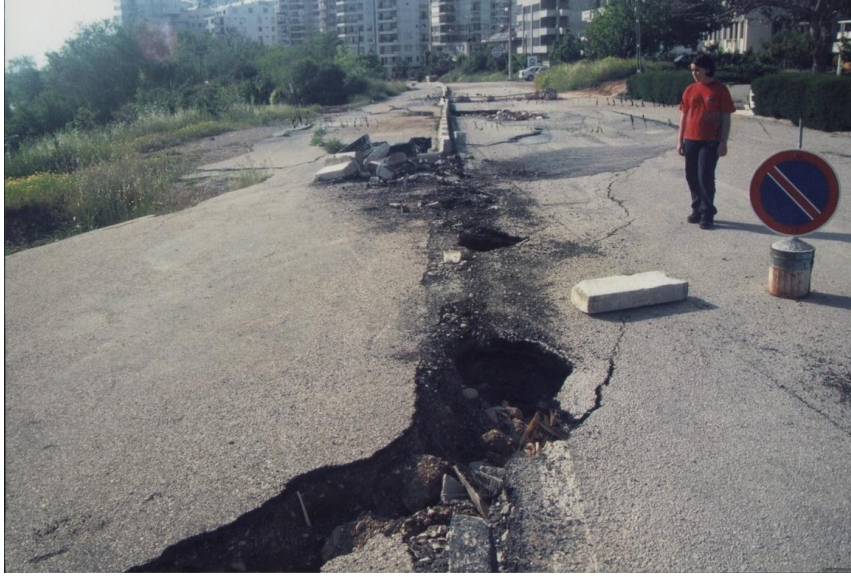
Foto 2: Eski Lara yolundaki göçmelere bağlı olarak gelişen deformasyonlar.
