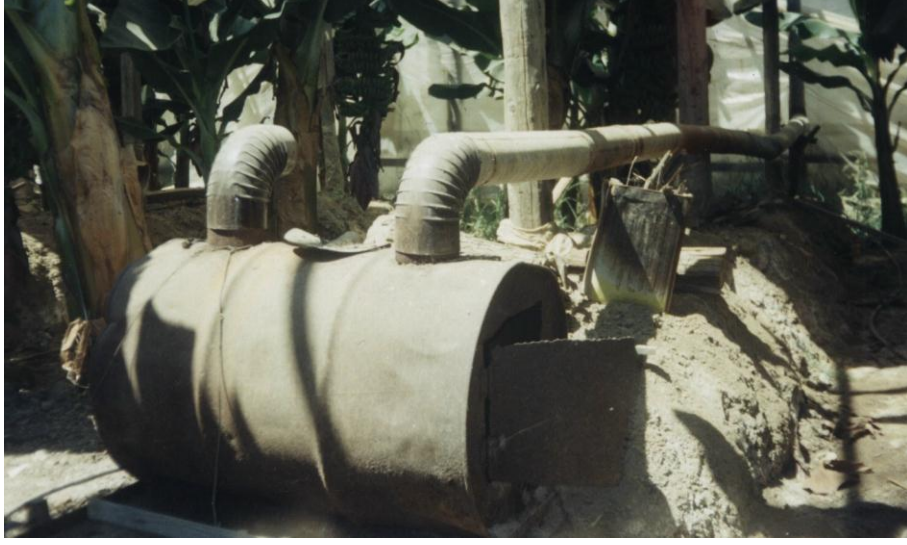
Fotoğraf 3. Seralarda ısıtma aracı olarak kullanılan bir soba
