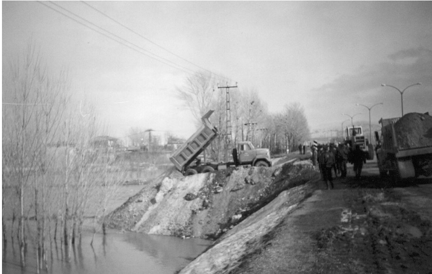
Fotoğraf 7. Ilica İlçesindeki taşkın iyileştirme çalışmaları. Çalışmada köprü ayakları tahkim edilmektedir.
