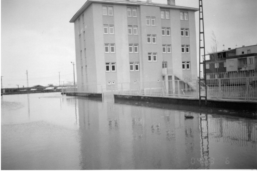
Fotoğraf 4. Su baskınına uğrayan binalardan birisi. Fotoğraf, ancak suların biraz çekilmesinin ardından çekilebilmiştir.
