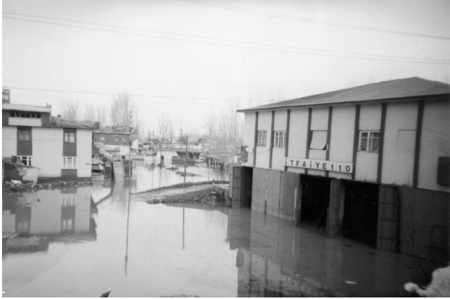
Fotoğraf 6. Ilica ilçesi Yeşil mahalle ve itfaiye binasının sellenmeden hemen sonraki durumu.
