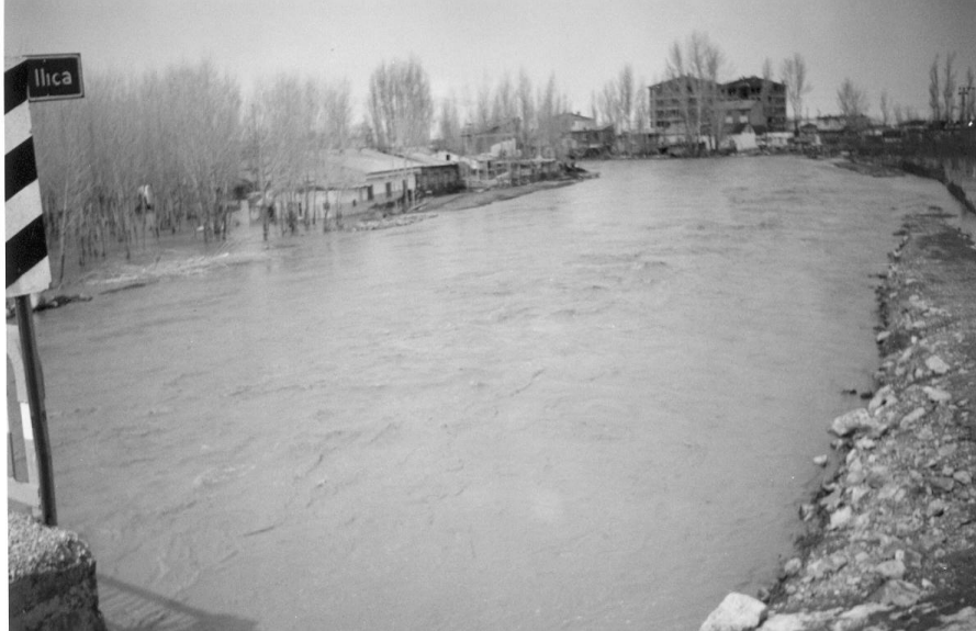
Fotoğraf 1. Bahçelievler de kanal seviyesinin altında inşa edilen konutlar ve taşkın etkisi.
