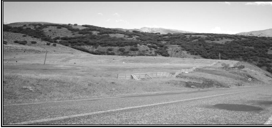
Fotoğraf 6. Erzurum-Bingöl karayolunda önceleri sadece Hacılar ve Karlıova arasında, birkaç yerde yapılmış olan kar perdelerinin sayısı artırılmaya başlanmıştır.
