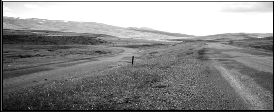
Fotoğraf 1. Kalencik Heyelanı nedeniyle yolun güzergâhı değiştirilmiştir (Solda eski karayolu sağdaki yeni karayolu).
