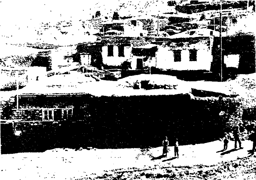
Fotoğraf 4. Karakale Köyü'nde Konut ve Eklentilerinin Görünüşü.
