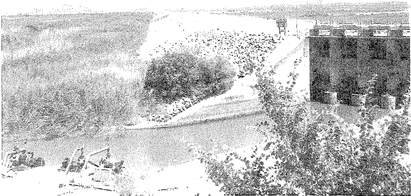
Foto: 2- Gölün doğusundaki set ve boşaltma kanalının regülatörü. Bu regülatör göl düzeyini 79 m.de tutar.
