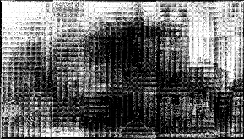
Fotoğraf 2. Aşkale'de son yıllarda çok katlı modern konutlar inşa edilmektedir.
