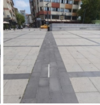
Fot.13: Yatay Aydınlatma Elemanı
