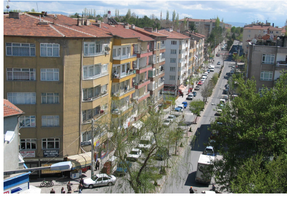
Foto 7. İstasyon Caddesi'nde çok katlı binalar
