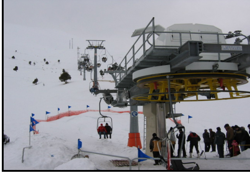
Fotoğraf 6. Yükseltisi 1670 m olan, 2 kişilik iskemleli ve sabit klemensli telesiyenin alt istasyonundan bir görünüm. 2000 yılında hizmete giren ve saatte 1000 kişi taşıma kapasitesine sahip telesiyej, 13 adet direk ve 134 iskemleden oluşmaktadır.
