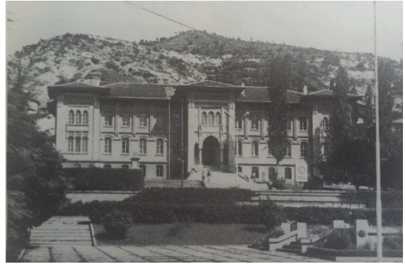
Fot. 1. Kastamonu Hükümet Konağı (Sözen, 1984: 64)
