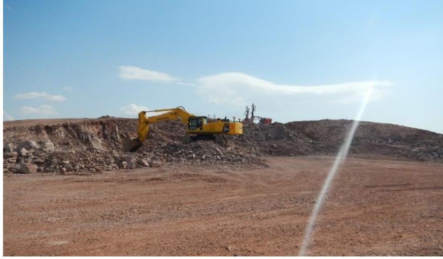
Şekil 4. Açık ocak örtü kazı işinden bir görünüm Figure 4. A view from the open pit cover excavation
