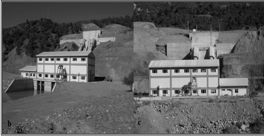
Fotoğraf 2. Reşadiye Hidroelektrik Santralleri: HES II ve HES III.
