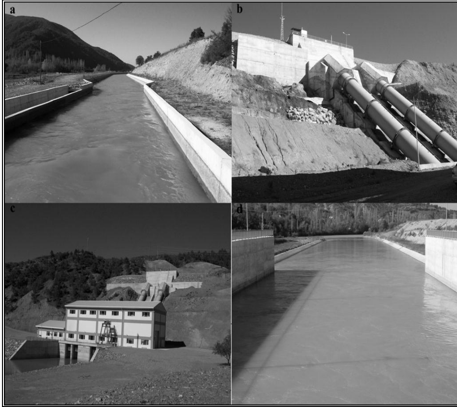
Fotoğraf 3. Reşadiye HES-3. Nehir tipi santrallerde bulunan belli başlı ünitelerden bazıları: a) İletim kanalı b) Cebri boru c) Santral binası d) Santral çıkış suyu.
