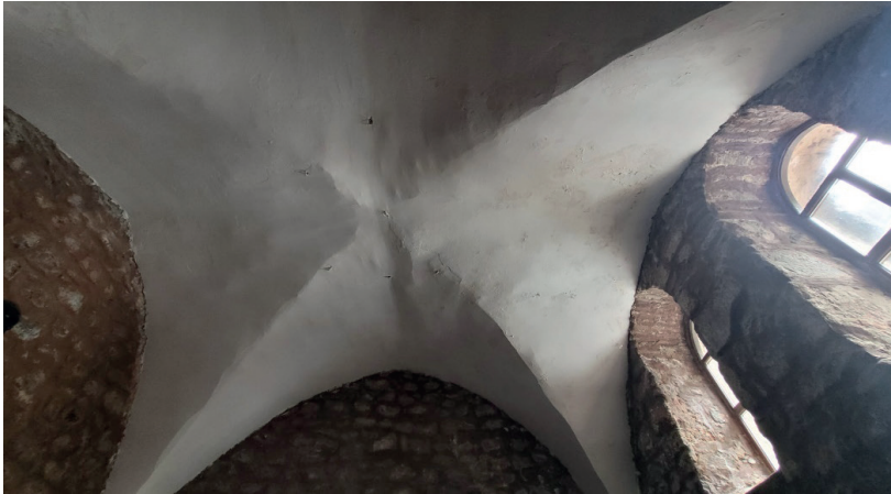
Resim 12: Taş Mektep, doğu oda, çapraz tonozun görünümü
