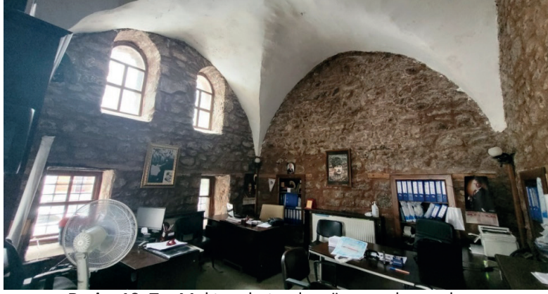
Resim 10: Taş Mektep, batı oda, güney ve kuzey duvar
