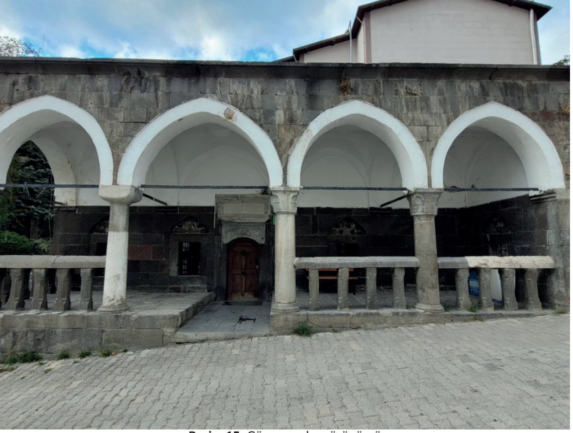
Resim 15: Güney cephe görünümü
