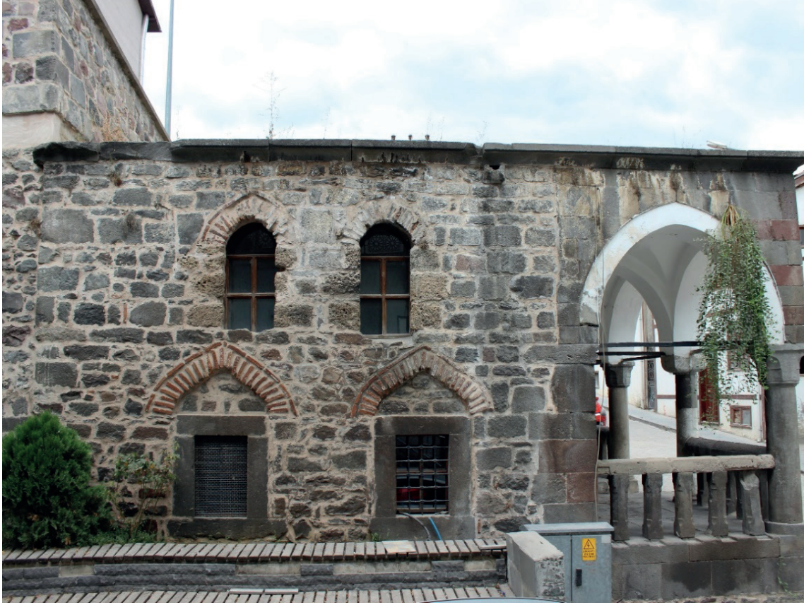
Resim 16: Taş Mektep, batı cephe görünümü
