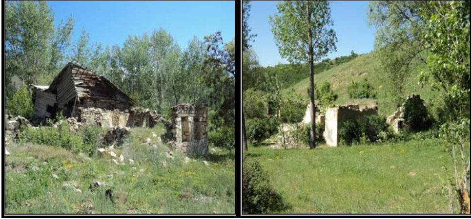
Fotoğraf 4. Mezraalardan geçmişte göç eden ailelere ait konut kalıntılarında oluşan metruk yapılar yörede göçün yoğunluğunu göz önüne sermektedir.
