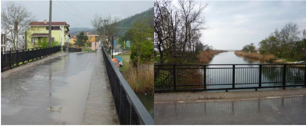
Şekil 16. Yeşilçay Köprüsü ve Göksu Deresi
