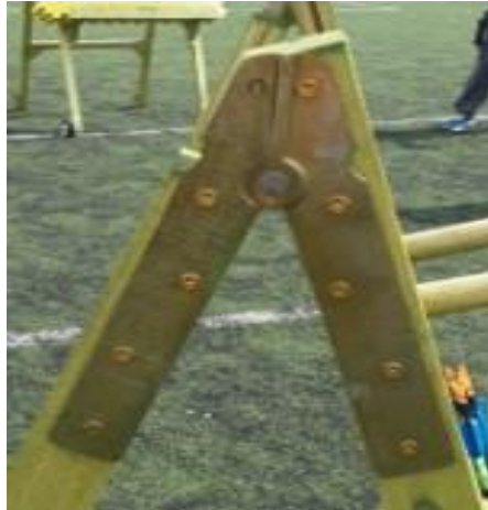
Şekil 1. Hedef ayağı tasarımında kullanılan merdiven makası görüntüsü
