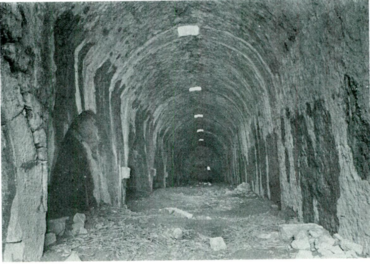
25 — Batı koridoru West corridor (Tükel arşivi neg. no. 35/209)
