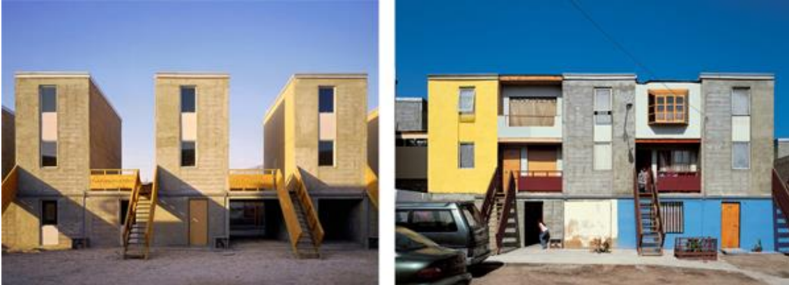
Şekil 5. Yarisı tamamlanmış ev ( Greenspan, 2016 )
