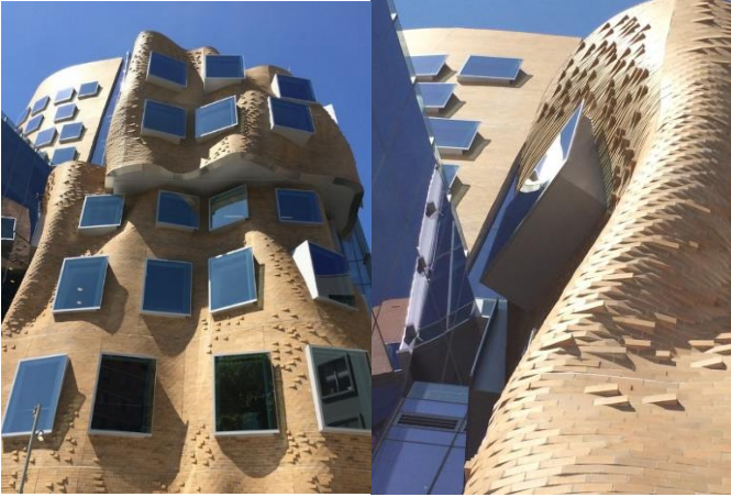
Görsel 4. Sydney's University of Technology tuğla ile örülmüş cephe detayı, Sydney
