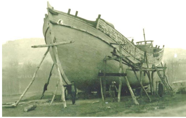
Şekil 14. VANLI gemisi Bartın’da inşa halinde 1965.
