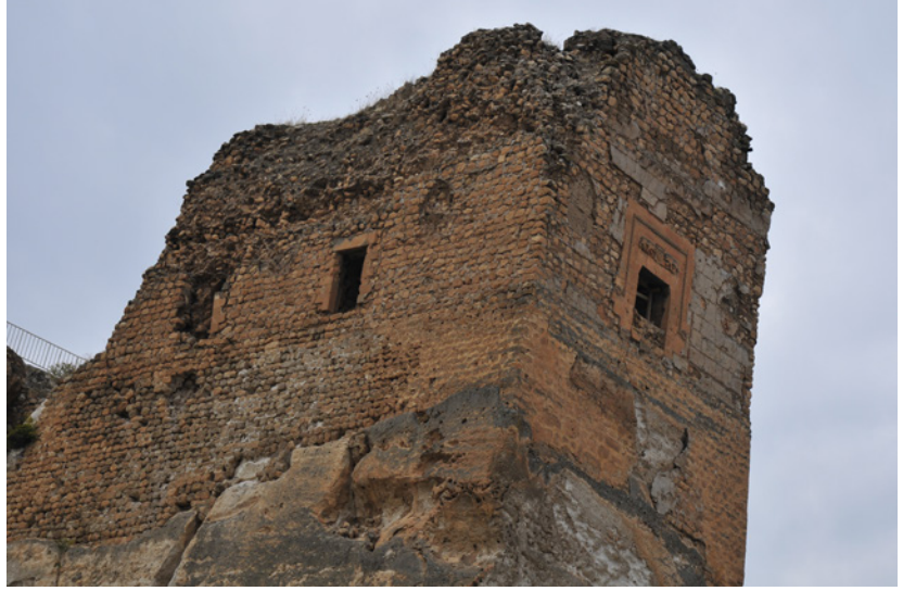
9 Küçük Saray'ın kuzeydoğu ve doğu cepheleri (Kazı Arşivi, 2017)
