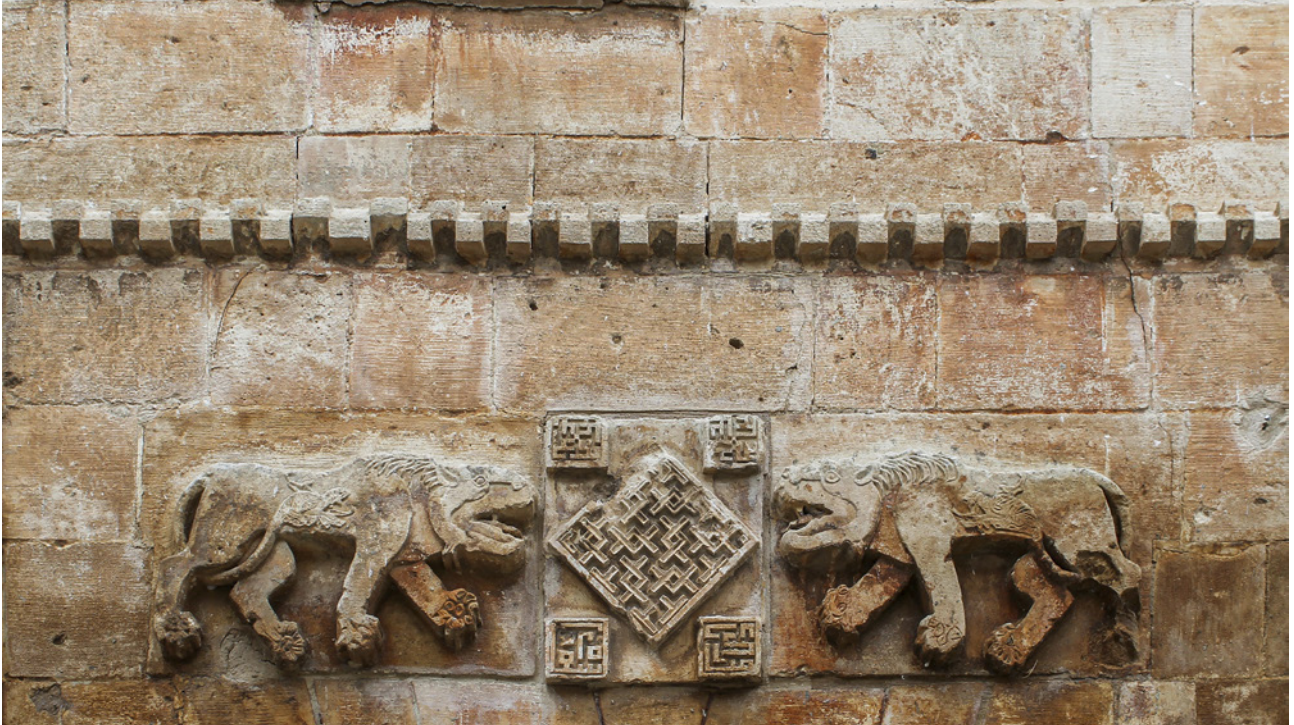
18 Küçük Saray'ın kuzeydoğu cephesindeki bezeme detayı, 2020
