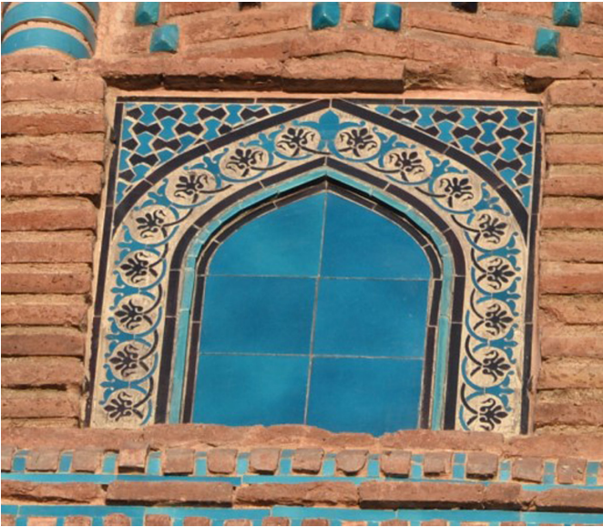
Resim 3. Medrese, Kuzey Minare Pabuç Kısmı, Batı Cephe, Birim Malzemede Yenileme (Konak)
