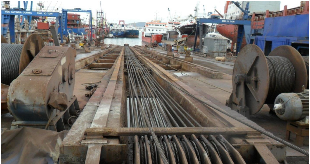
Şekil 2. Deprem performansı incelenecek betonarme raylı kızak görüntüsü.
