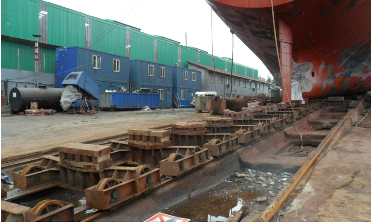
Şekil 3. Deprem performansı incelenecek betonarme raylı kızak görüntüsü.
