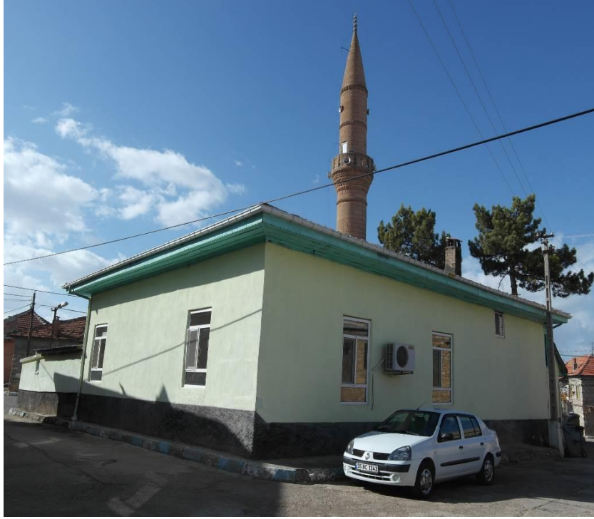
Resim 3. Güney ve doğu cephe görünümü
