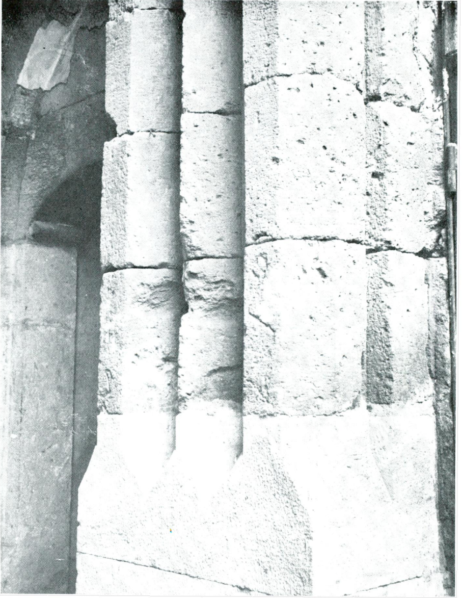
Res. 14 — Kayseri, Hacı Kılıç medresesi giriş eyvanında kemer profili ve camiye giren oda kapısı.
