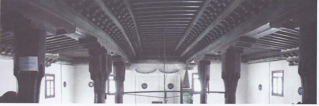
Foto. 5 - Ayaş Ulu Camii, harim, tavan sistemi, görünüş.
