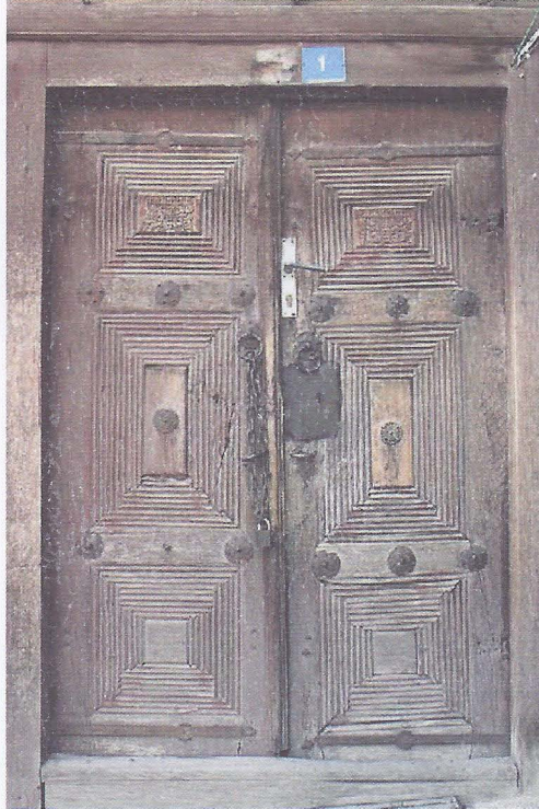
Foto. 2- Ayas Ulu Camii, doğu cephesi, giriş kapısı.
