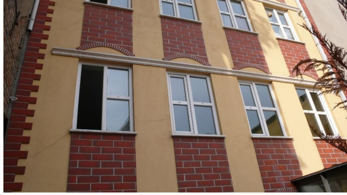
Şekil 12. Karaköy Loft dış cephe (Erdemir, 2015)
