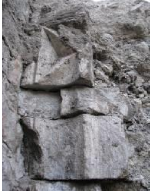
Resim 4: Güney cephesi süsleme detayı.
