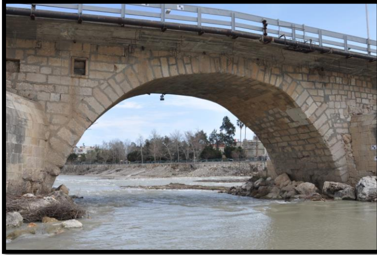
Fotoğraf 2: Köprü'nün Daha Önce Eğimli Olduğunu Gösteren Detay
