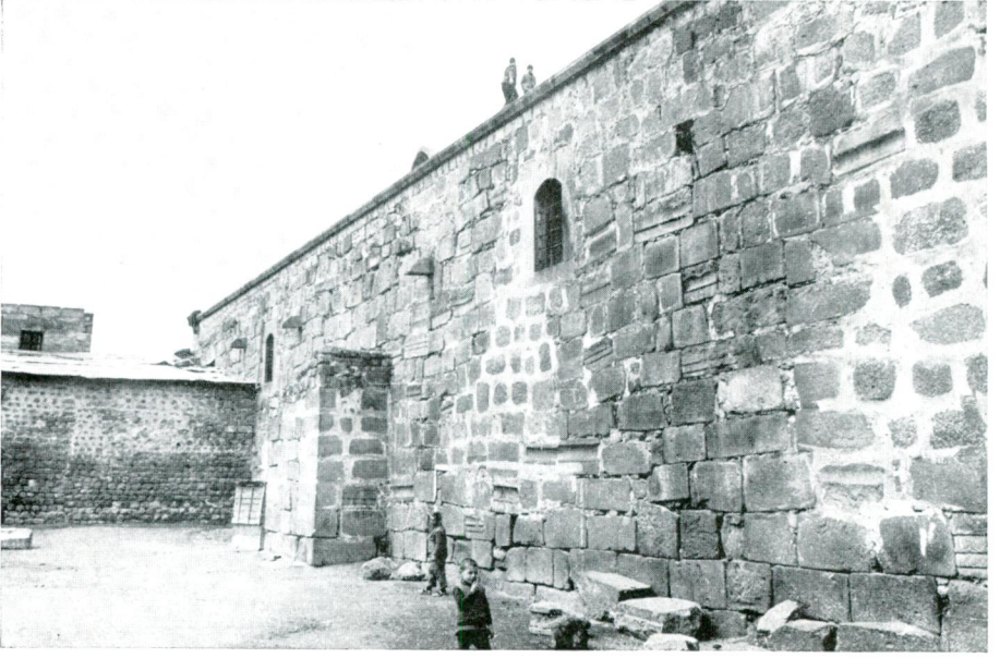
Resim 4 — Hacı Kılıç camisi mihrap duvarı.
