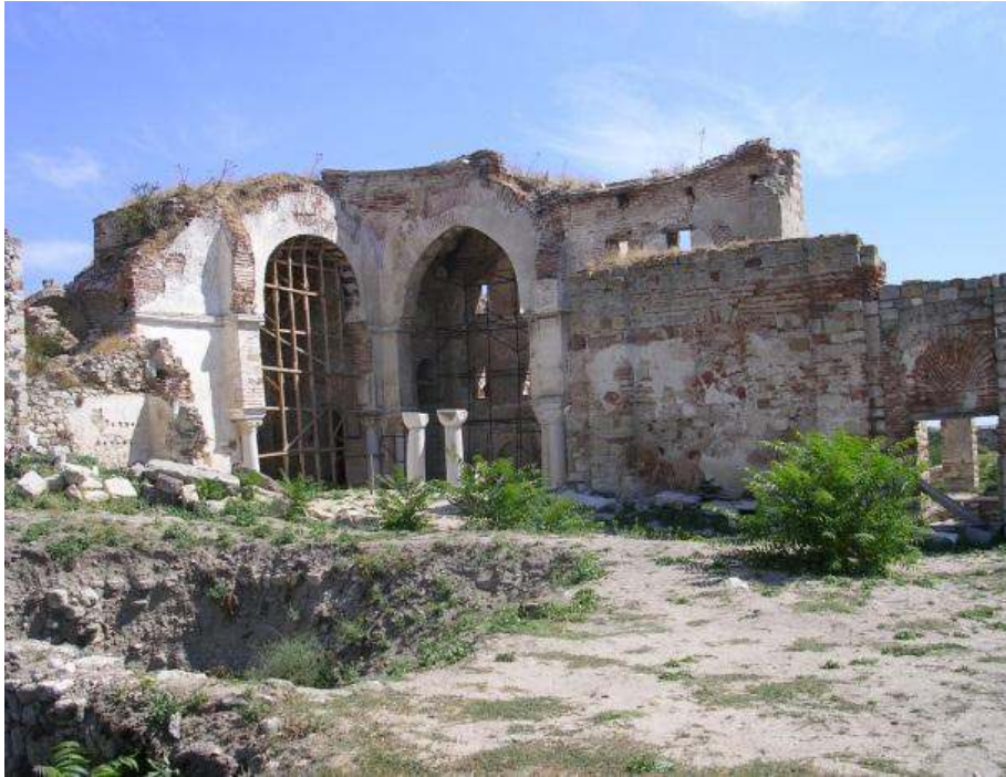
Fig. 15 Tahrip olmuş kuzey cephe (H. Günözü)
