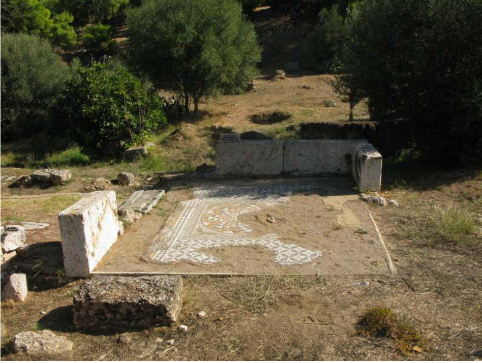
Fig. 3 İklim şartlarının ve ortam koşullarının elverişli olduğu alanlarda, çatı oluşturulmadan, düzenli bakım yapılarak korunan taban mozaïği
