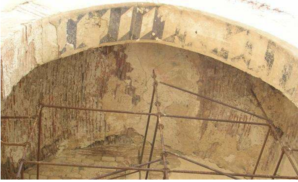
Fig. 38 Kemerlerde bulunan üç boyutlu testere diři motifi (H. Günözü)
