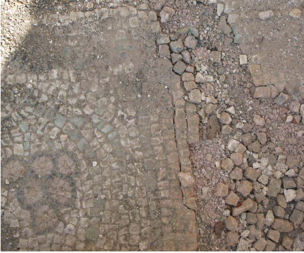
Fig. 7 Yeterli koruma önlemi alınmayan, periyodik kontrol ve bakımı yapılmayan taban mozağının tesseralarında dağılıma
