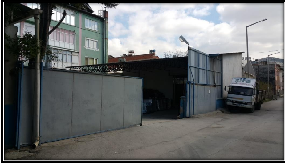
Şekil 8. İnönü Mahallesi'ndeki Depolama Alanları
